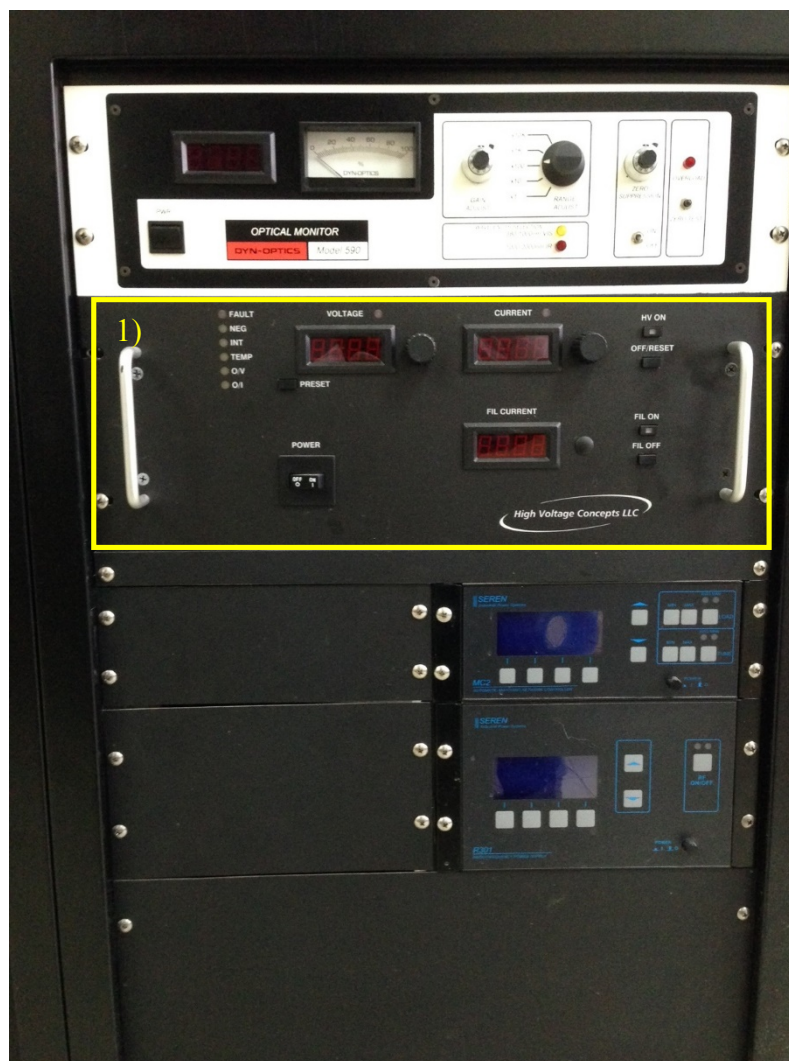
Рисунок 2.6. – Нижний блок электроаппаратуры установки вакуумного напыления TORR International.
