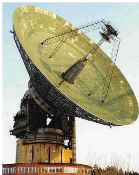
Рис. 20. 64-метровые полноповоротные антенны ТНА-1500, расположенные в центре космической связи «Медвежьи Озера» под Москвой и в г. Калязине, Тверской области. Первая построена по схеме Грегори, вторая – Кассегрена.
