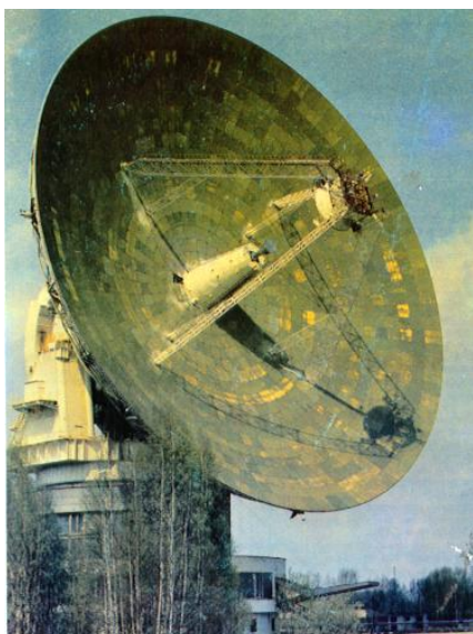
Рис. 20. 64-метровые полноповоротные антенны ТНА-1500, расположенные в центре космической связи «Медвежьи Озера» под Москвой и в г. Калязине, Тверской области. Первая построена по схеме Грегори, вторая – Кассегрена.
