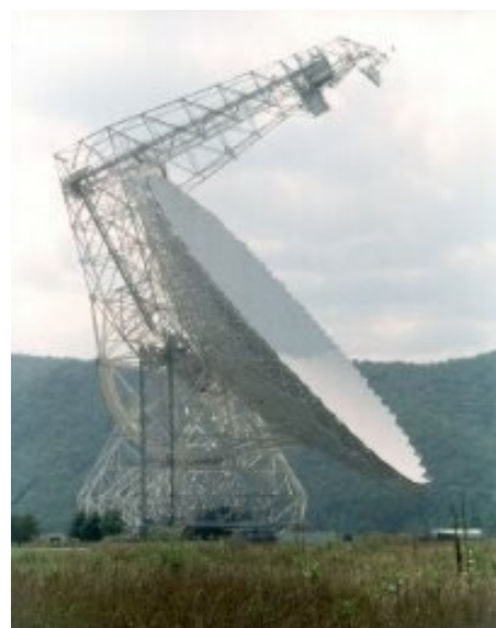
Рис. 17. Новый 100-метровый радиотелескоп обсерватории Green Bank (США). Несимметричная вырезка 100м*110м из 208- метрового параболоида. Рабочие частоты до 50 (100) ГГц.
