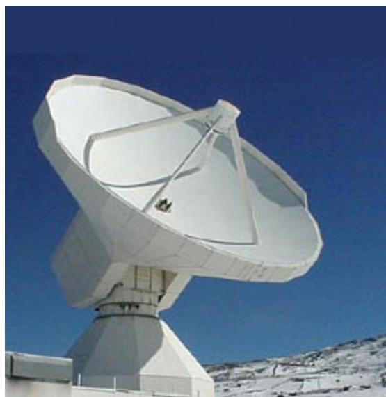
Рис. 22. 30-метровая полноповоротная зеркальная антенна миллиметрового диапазона в Пико-Велета, Испания.
