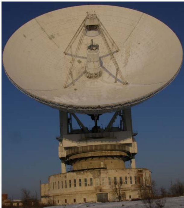
Рис. 5. 70-метровая зеркальная полноповоротная параболическая антенна центра космической связи «Уссурийск», Россия.
