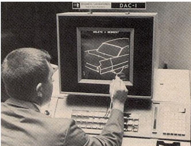
Рис. 1.5. первая графическая система *DAC-1*
